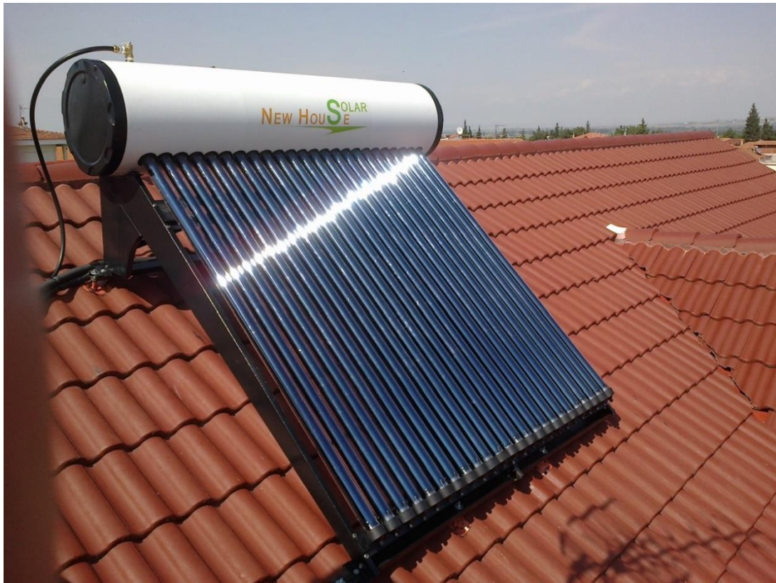
Εικόνα 1.2: Ηλιακό θερμικό με συμβατικό συλλέκτη σωλήνων κενού [9]
