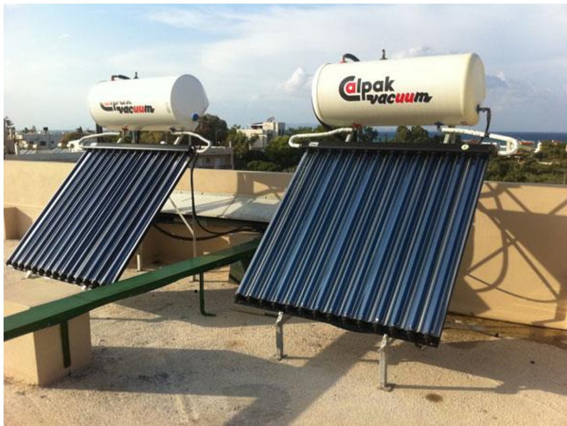
Εικόνα 2.11: Ηλιακά θερμικά συστήματα, με συλλέκτη σωλήνων κενού και CPC παραβολικό ανακλαστήρα, τοποθετημένα σε ταράτσα κτιρίου [39]
