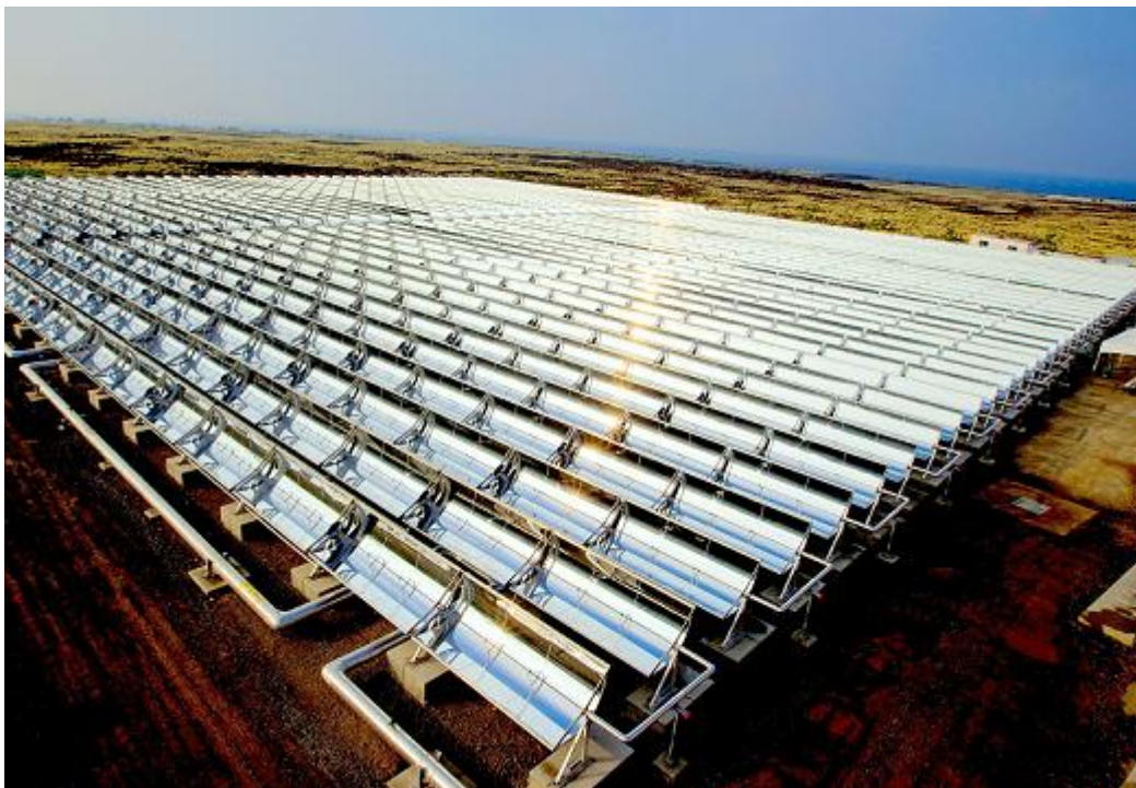
Εικόνα 1.4: Συγκεντρωτικοί συλλέκτες παραβολικής «λεκάνης» (parabolic trough) [13]
